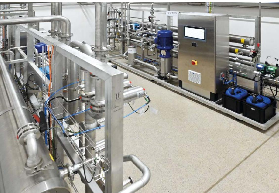
■ Abb. 1: Zwei baugleiche Grünbeck-Umkehrosmoseanlagen vom Typ RK-X 20.000 S hat Auerbräu im Gewölbekeller installiert. Jede von ihnen produziert bis zu 20 m<sup>3</sup> vollentsalztes Wasser pro Stunde.
