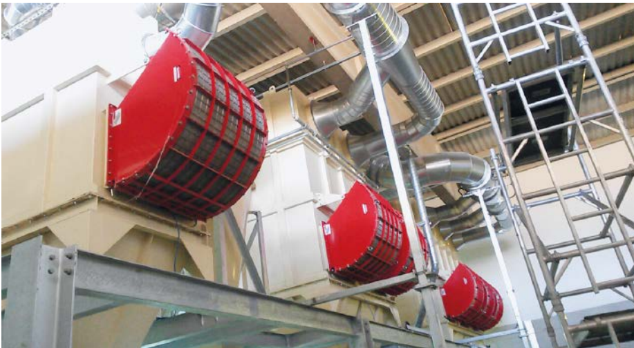
■ Abb. 3: Flammenlose Druckentlastungen – hier im Bild die rechteckige Version R-IQ – lassen die Druckwelle entweichen und schützen so Anlagen und Maschinen; Flammen und Partikel werden zugleich sicher zurückgehalten.
