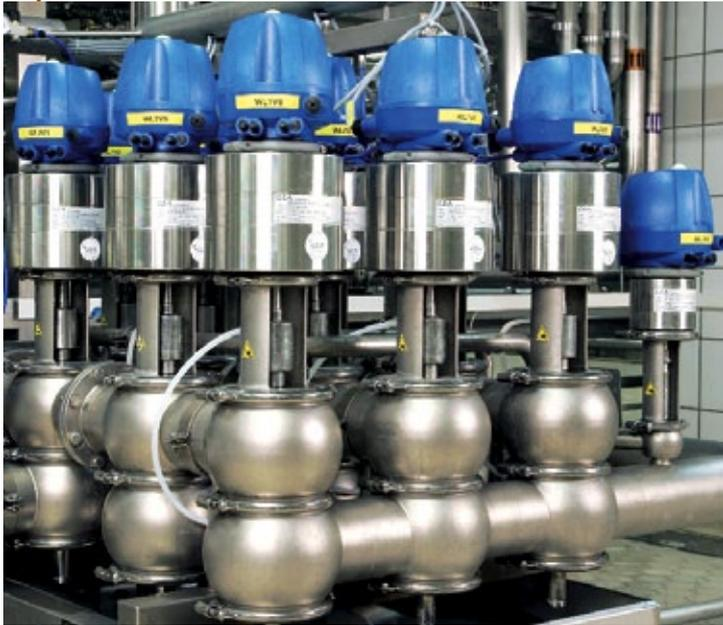
Varivent Ventile sind eine Schlüsselkomponente für festverrohrte Prozessanlagen, funktionssicher, CIP/SIP-gerecht und wartungsarm. Dies sind wesentliche Faktoren für
