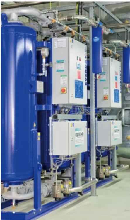
■ Abb. 2: Everdry FRA-V-Druckluft-Adsorptionstrockner. © Beko Technolo
