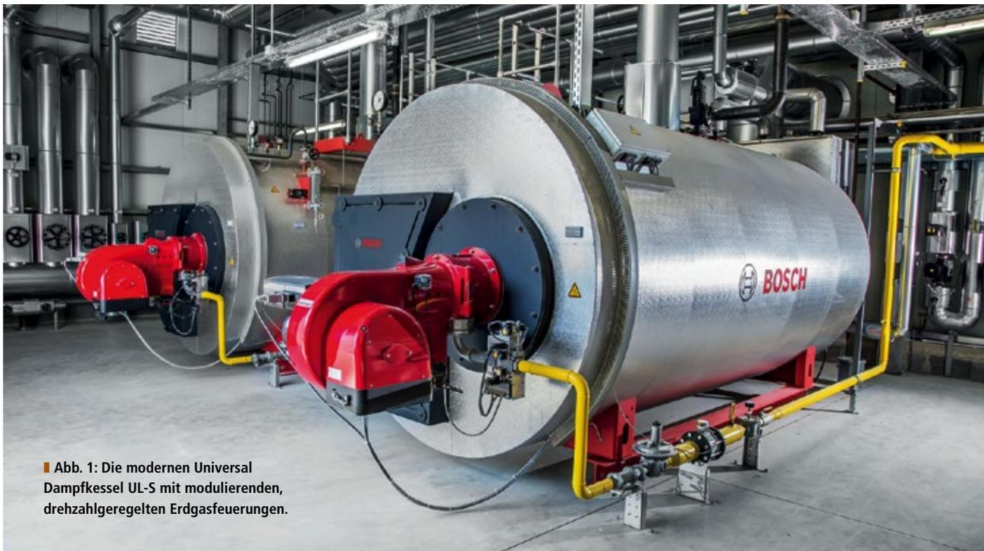
■ Abb. 1: Die modernen Universal Dampfkessel UL-S mit modulierenden, drehzahlgeregelten Erdgasfeuerungen.
