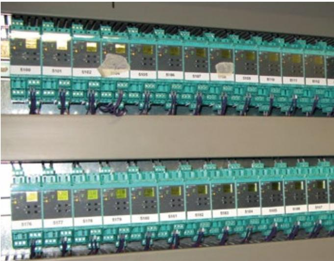
■ Abb. 2: Die Signaltrenner gehören zum K-System von Pepperl + Fuchs und werden auf dem Power Rail montiert.
