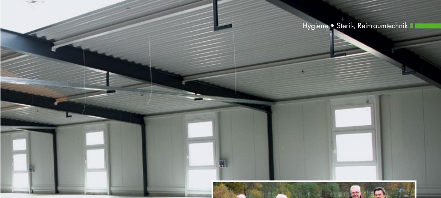
■ **Abb. 2:** Hygiene als Bauziel: Dazu wurden unnütze Flächen möglichst minimiert und die gesamte Stahlkonstruktion mit lösemittelfreiem Lack beschichtet. Dank einer Silikonabdichtung an den Stoßfugen lässt sich die Halle auch mit Hochdruckgeräten problemlos reinigen.
