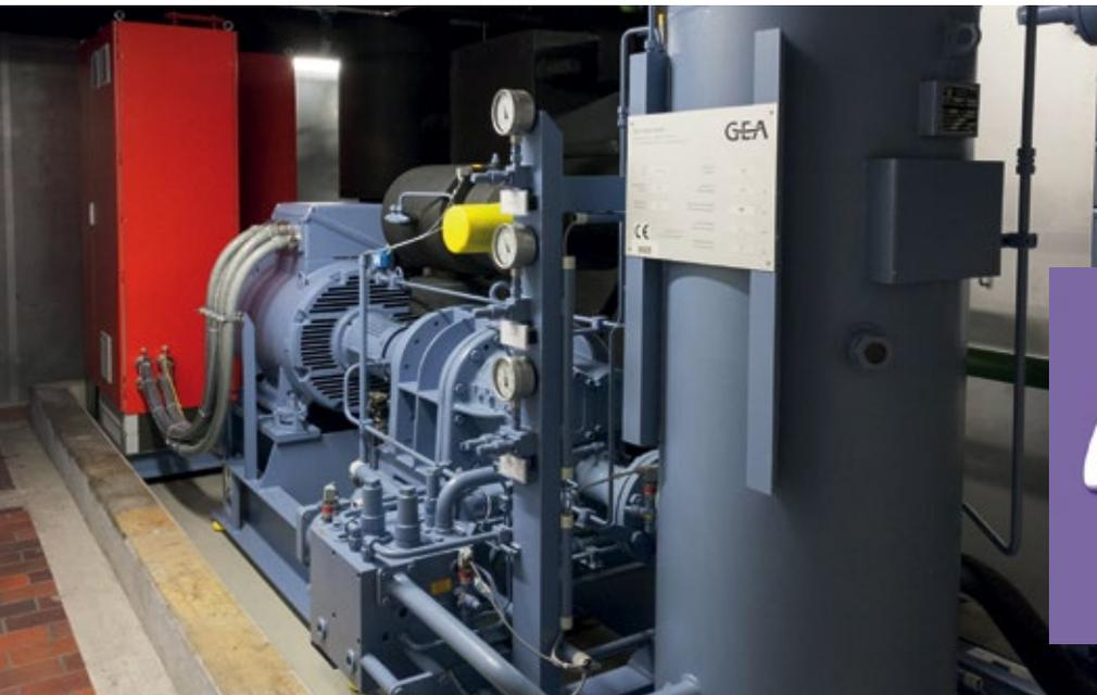
■ Abb. 1: Der GEA Grasso Kaltwassererzeuger aus der FX-Baureihe ist mit einem Schraubenverdichter offener Bauart ausgestattet. Dieser zeichnet sich durch eine stufenlose Leistungsregelung am Frequenzumrichter und ein variables Volumenverhältnis aus. © Kraft Foods
