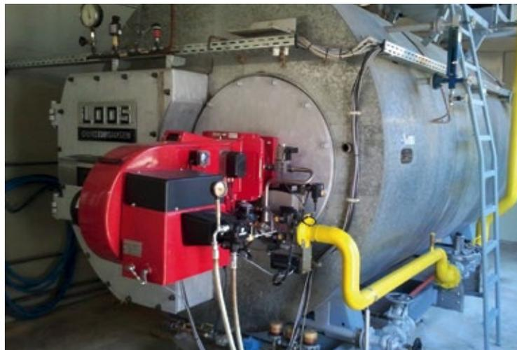
■ Abb. 3: Mehr Effizienz: Die neue Feuerung mit Drehzahl- und Sauerstoffregelung. © Bosch Industriekessel GmbH
