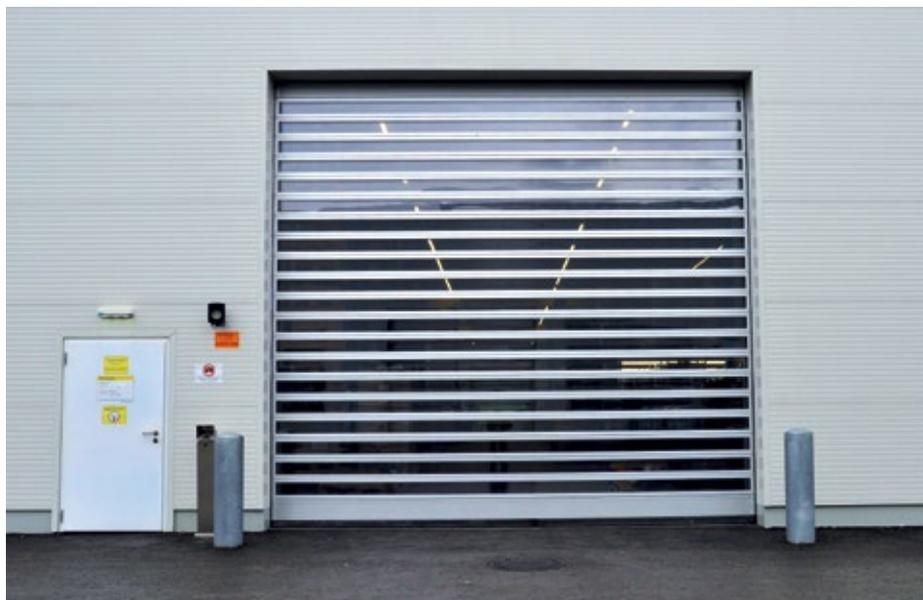
■ Abb.: Efaflex Schnelllauf-Turbotore STT aus Acrylglas SAN gefertigt, sind lichtdurchlässiger als Glas und haben nur einen Bruchteil von dessen Gewicht.
