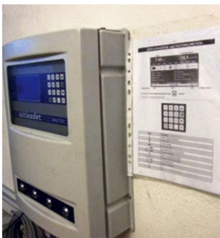
■ Abb. 3: Eine intelligente bedarfsabhängige Verbundsteuerung steuert die Druckluftherzeugung.
