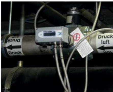
■ **Abb. 1:** Messtechnik für das Energiemanagement ISO 50001: Druckluftzähler STA-Wi DN100, Drucktaupunktsenor STA-Wf und Drucksensor an einem Messpunkt bei Firma Naarmann.
