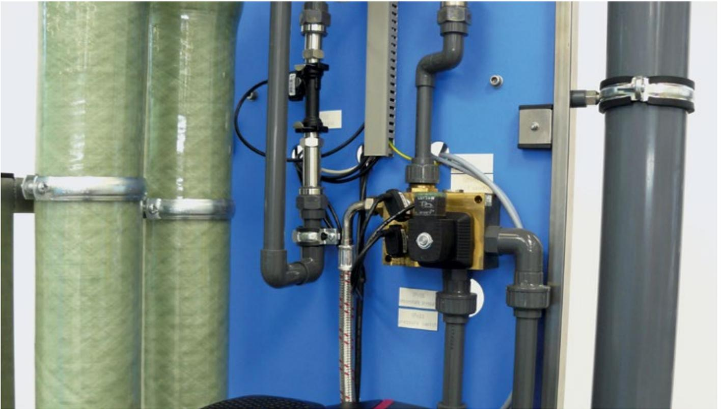
Abb. 3: Die digitale Technik bietet neue Möglichkeiten, eine Anlage und deren Zustand transparent zu machen. Hier: Kombination eines MGE-Motors mit Sensoren bei einer Umkehrosmose-Anlage von Herco.
