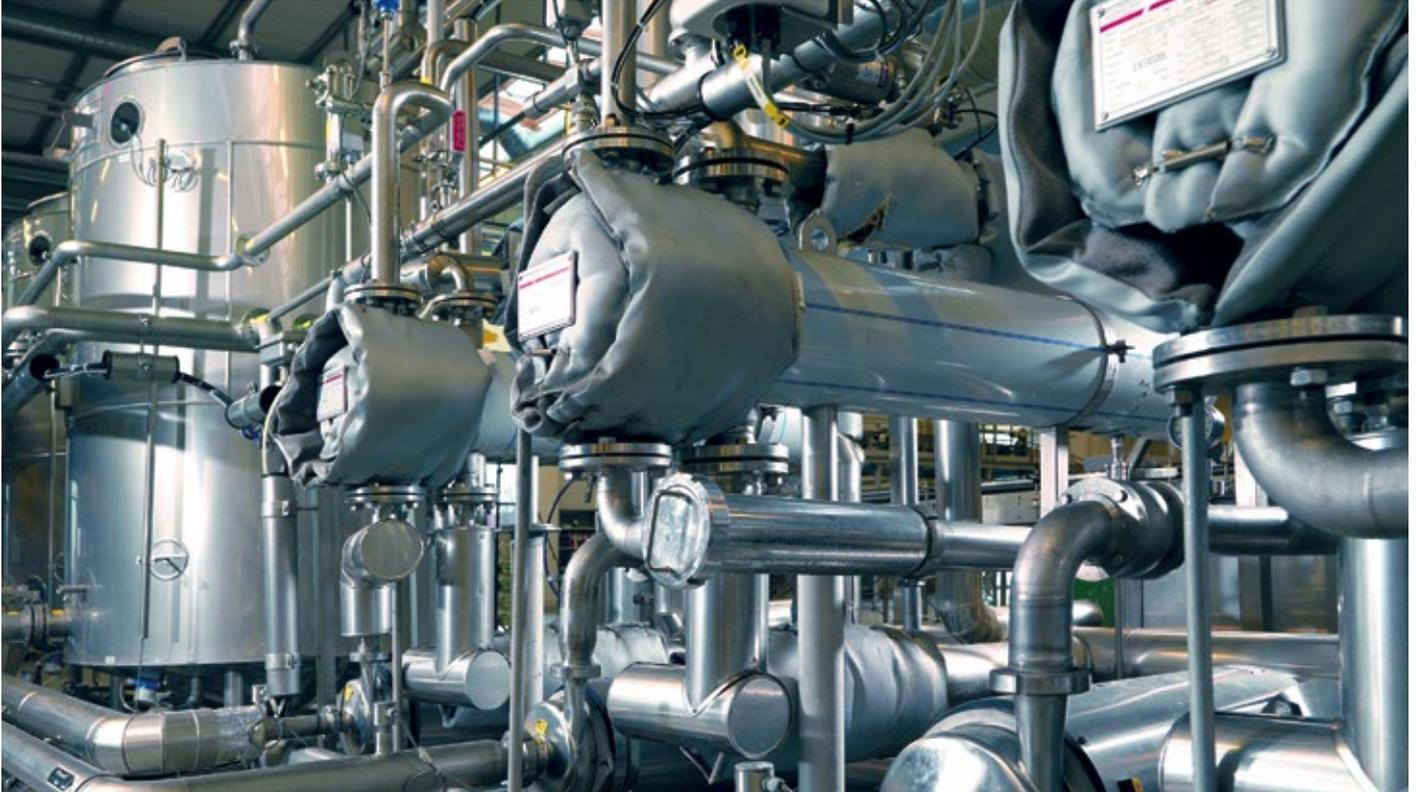
■ **Abb. 1:** In der Lebensmittelindustrie sind auch bei den Pumpen Systemlösungen gefragt, die sich dem Produktionsprozess anpassen. Grundfos nennt das „Isolutions“. Hier: CIP-Anlage einer Brauerei mit F+B-Hygia-Pumpen der Marke Hilge.
