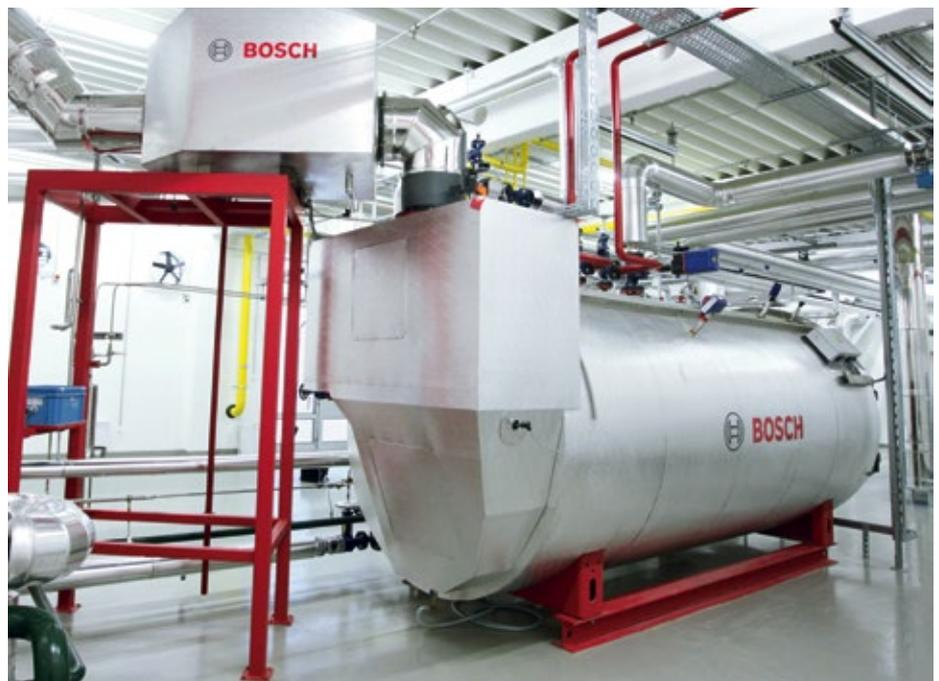
■ Abb. 3: Energieeffizienter Bosch Dampfkessel Universal UL-S mit integriertem Economiser und Brennwärmetauscher.
