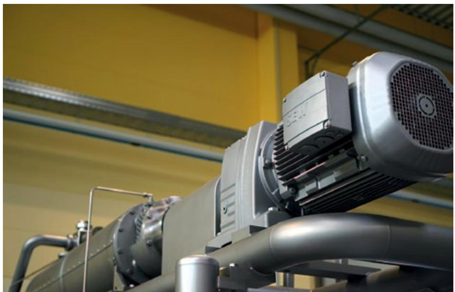
■ Abb. 3: SEW-Getriebemotoren treiben die Tablierrotoren der kontinuierlichen Tabliermaschine Micron an.
