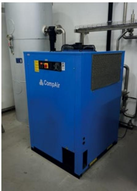
■ **Abb. 5:** Ein energiesparender Kältetrockner von Compair mit Scrollkompressor entfernt die Restfeuchte aus der verdichteten Luft, bevor sie in der Krones Contiform Streckblasmaschine den Druckstoß für die PET-Flaschenproduktion ausführt.
