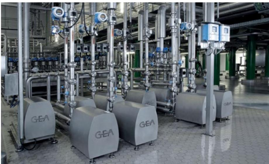
■ **Abb. 4:** Die Pumpen der Serie GEA Tuchenhagen TP überzeugen Anwender in Nahrungsmittel- und Pharmaanwendungen durch ihr leicht zu reinigendes, tottraumfreies Design, Wartungsarmut und die einfache Ersatzteilkhaltung.
