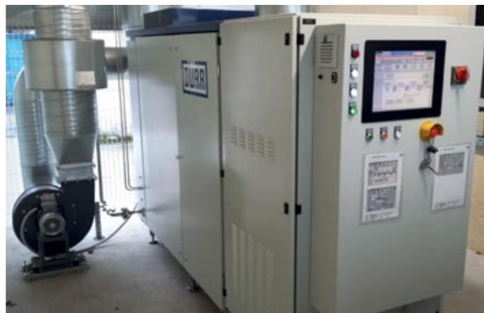
■ **Abb. 3:** Die neue Turbine erzeugt neben 100 kW Strom auch Abgase. Diese durchströmen einen speziellen Vierzugkessel und produzieren so 0,5 t/h Satteldampf, der die Grundlast im Betrieb abdeckt. Bei einem höheren Bedarf kann zusätzlich ein stufenloser Gasbrenner betrieben werden, sodass im Kombibetrieb bis zu 2,5 t/h Satteldampf erzeugt werden.
