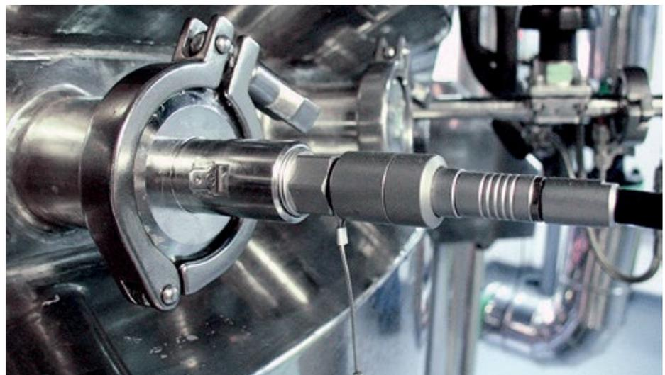
■ **Abb. 4:** Im Fermenter unterstützt der Zellwachstums- und Biomassesensor OUSBT66 bei der Nährstoffdosierung und dem richtigen Timing für die Produkternte.
