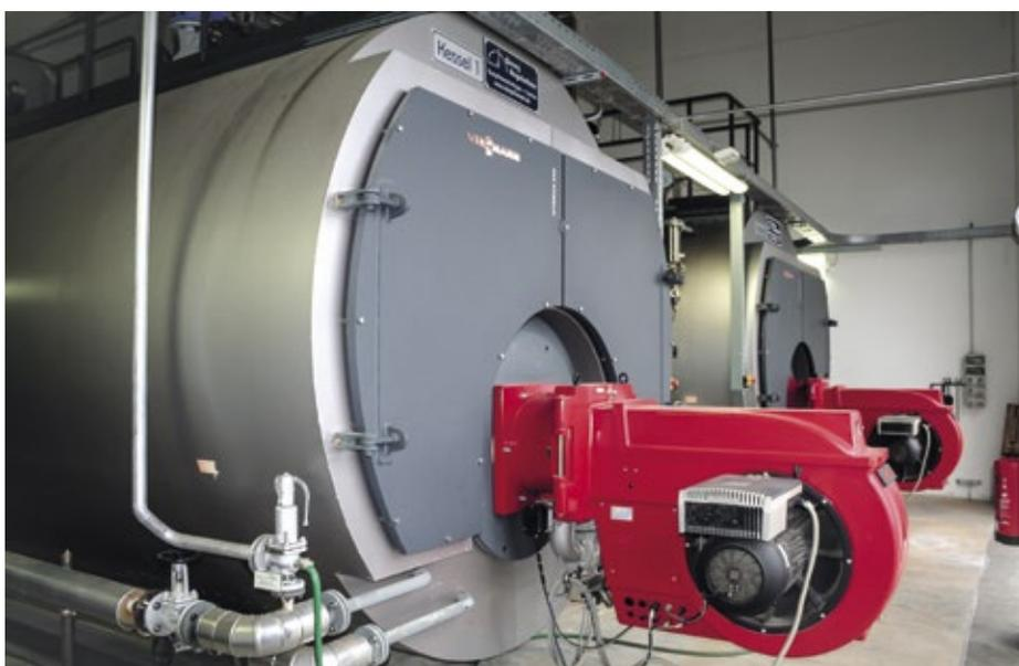
■ Abb. 3: In der neu installierten Dampfkesselanlage erzeugen zwei Hochdruck-Dampferzeuger vom Typ Vitomax HS Dampf mit einem Druck von 16 bar und einer Leistung von zweimal 10 t pro Stunde.
