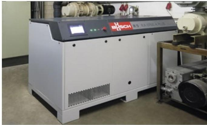
■ Abb. 2: Die neue Vakuumpumpe R 5 0760 A Plus von Busch testweise eingebaut in ein vorhandenes zentrales Vakuumsystem.
