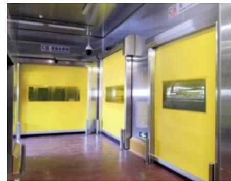
■ Abb. 3: Auf Wunsch des Eigentümers sind alle 53 EFA-SRT-L Eco mit dem Anfahrschutz EFA-EAS ergänzt. Diese Schutzeinrichtung verhindert bei einem eventuellen Crash weitgehend teure Schäden am Torblatt.
