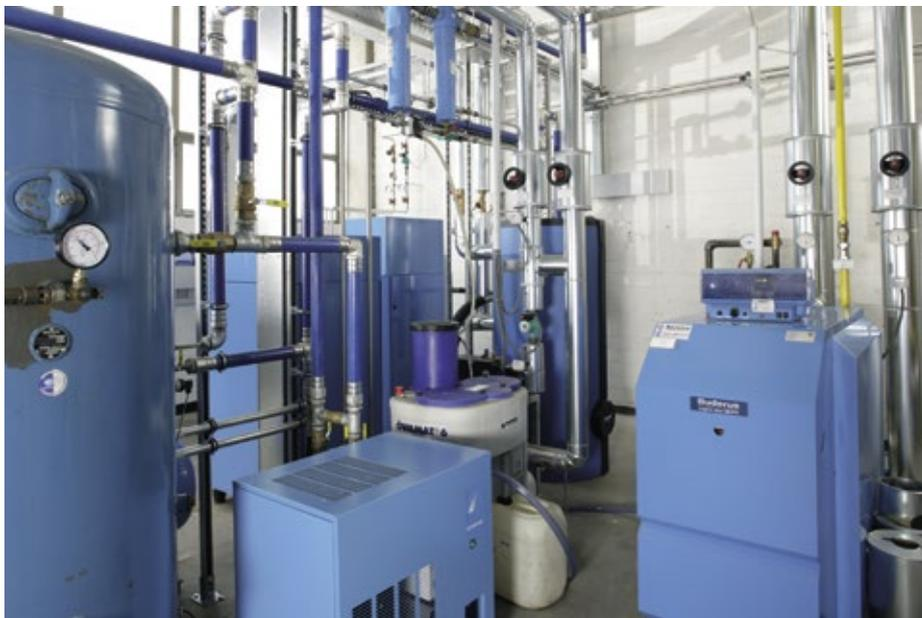
■ **Abb. 1:** Die Wärme, die bei der Druckluftherzeugung entsteht, kann z. B. zu Heizzwecken genutzt werden – wie hier am Firmensitz von Boge in Bielefeld.
