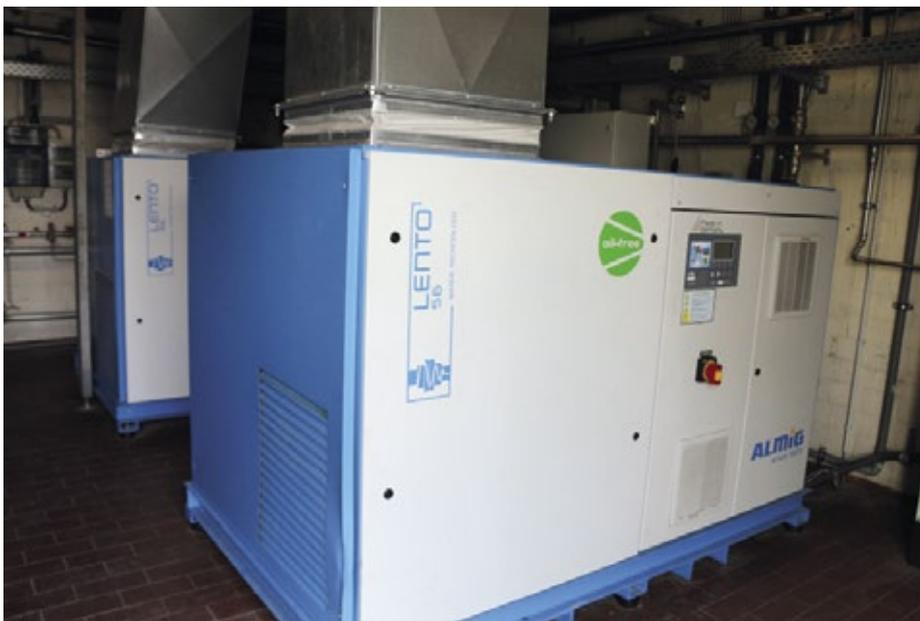
■ **Abb. 3:** Bad Meinberger setzt auf ölfreie wassereingespritzte Schraubenkompressoren der Lento-Baureihe von Almig.
