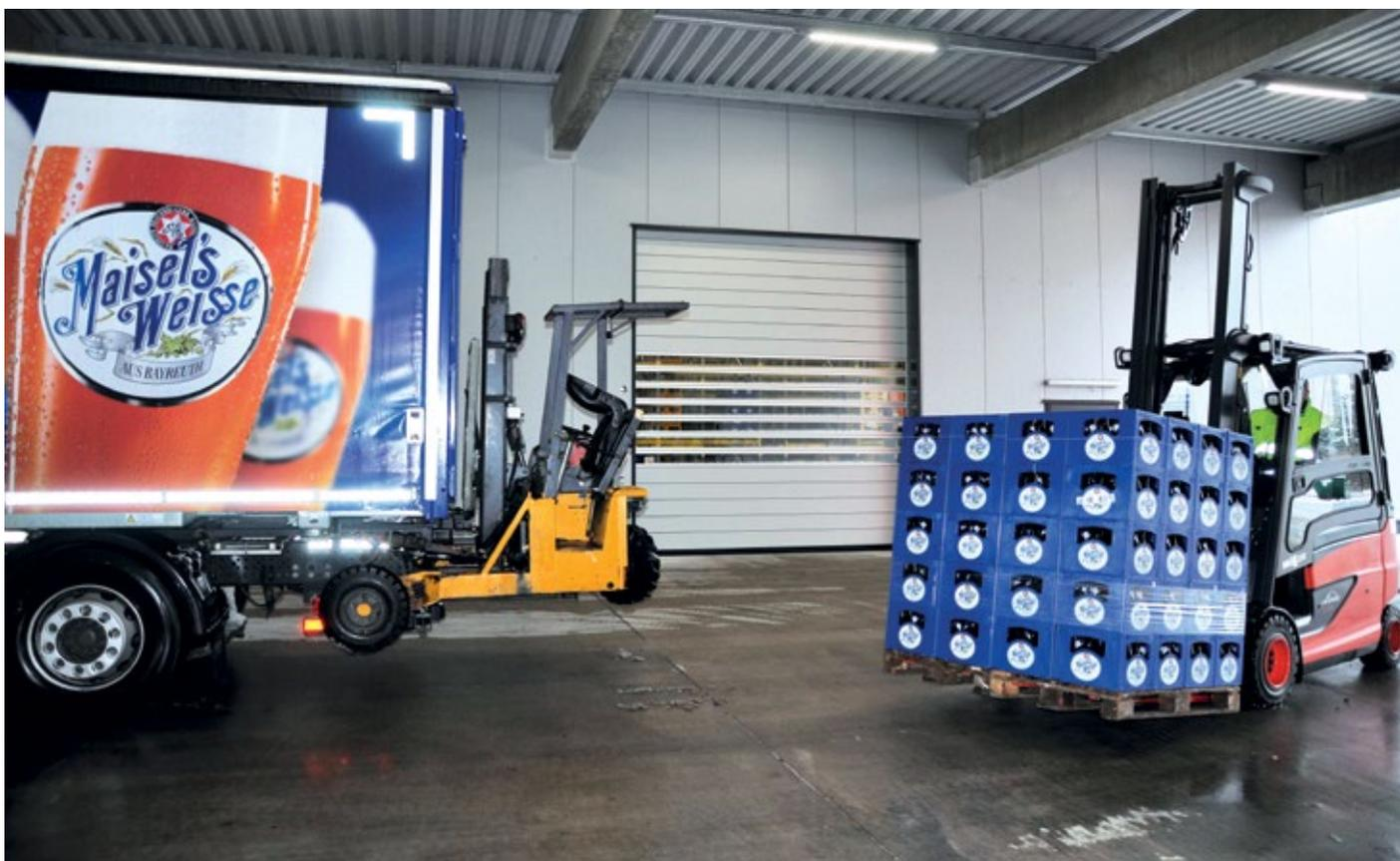
Abb. 1: Zwischen 150 und 200 Mal pro Tag öffnen und schließen die insgesamt neun Schnelllauf-Spiraltore EFA-SST-L Premium in den Hallen von Lisa Mai Getränke in Bayreuth. Das sind mindestens 50.000 Öffnungszyklen pro Jahr.
