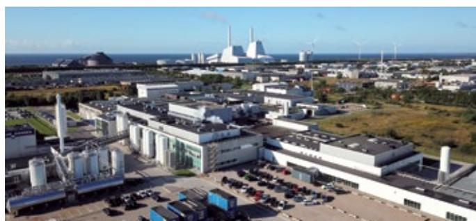
Fermentationsprojekt vier Produktionslinien: zwei Linien mit je 45 m<sup>3</sup> Fermentervolumen sowie zwei Linien mit je 100 m<sup>3</sup> Fermentervolumen und ist damit die weltweit größte Produktionsstätte dieser Art.
