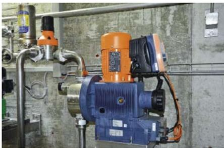
■ **Abb. 2:** Im Brauhaus kommen die Motor-Membrandosierpumpen Sigma zum Einsatz. Sie dosieren z. B. 50-prozentige Natronlauge in die automatischen Cleaning in Place Anlagen.
