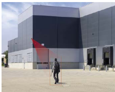
■ Abb. 3: Moderne Videotechnik sorgt mittels intelligenter Bildanalyse dafür, dass ein Schaden gar nicht erst entsteht, da rechtzeitig interveniert werden kann.
