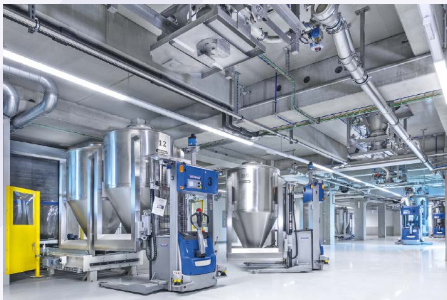
■ Abb. 2: Die Container werden mittels fahrerlosem Transportsystem (FTS) durch die Anlage bewegt.
