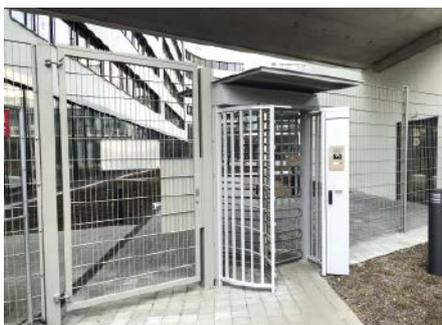
■ **Abb. 3: Zugangstor mit Personenvereinzellung und Kameraüberwachung.**
