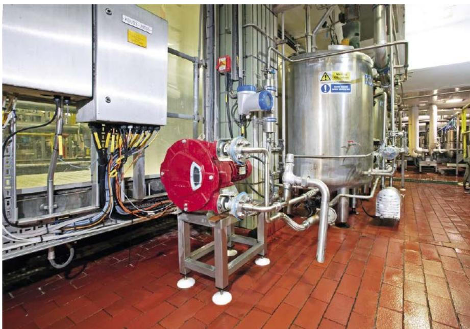
**Abb. 5: Bredel Schlauchpumpen fördern Kieselgur zur Filtrierung. Durch den Einsatz der Bredel 25 konnte der Eintrag von gelöstem Sauerstoff bei Magor zuverlässig unterbunden werden.**
