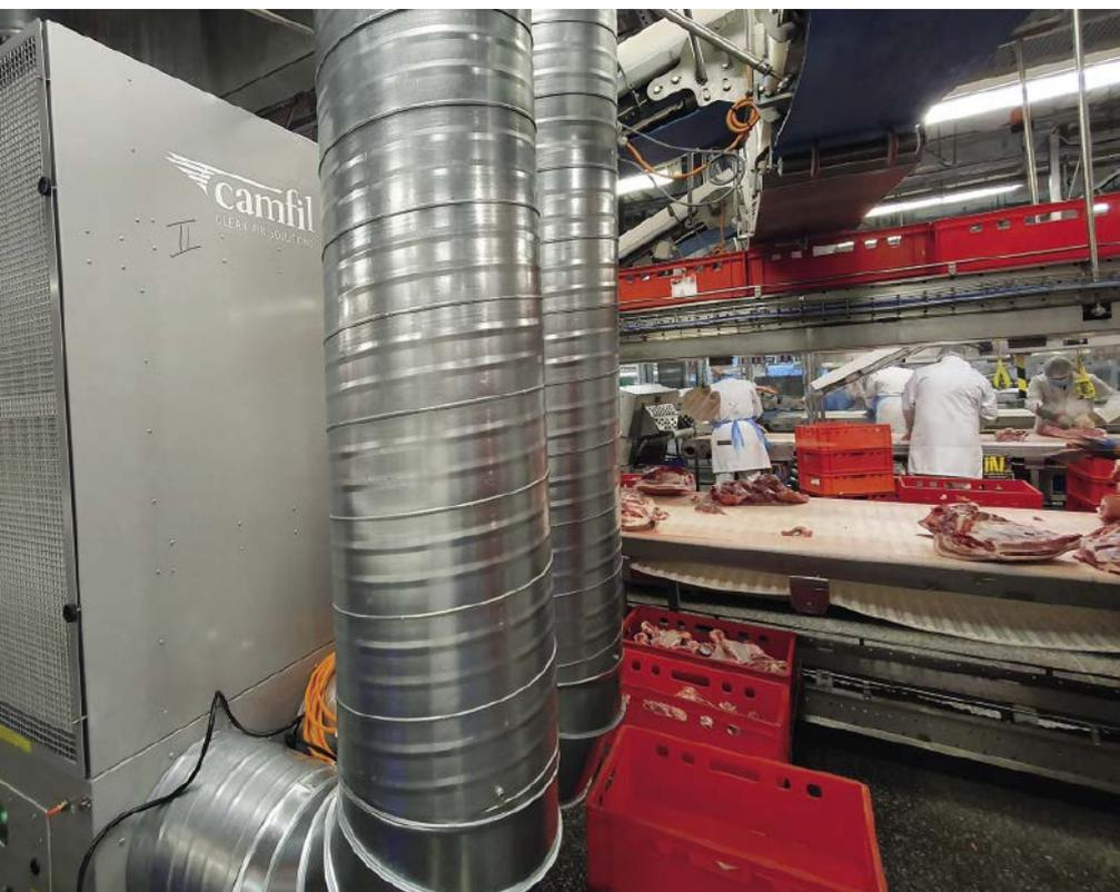
■ **Abb. 1:** Im Bereich der Fleischzerlegung am Tönnies Hauptsitz ist der Luftreiniger CC 6000 mit Hochleistungsfiltern HEPA H14 ausgestattet. Kurz nach Inbetriebnahme in der Produktionshalle reduzierte sich die Partikelbelastung um mehr als die Hälfte.
