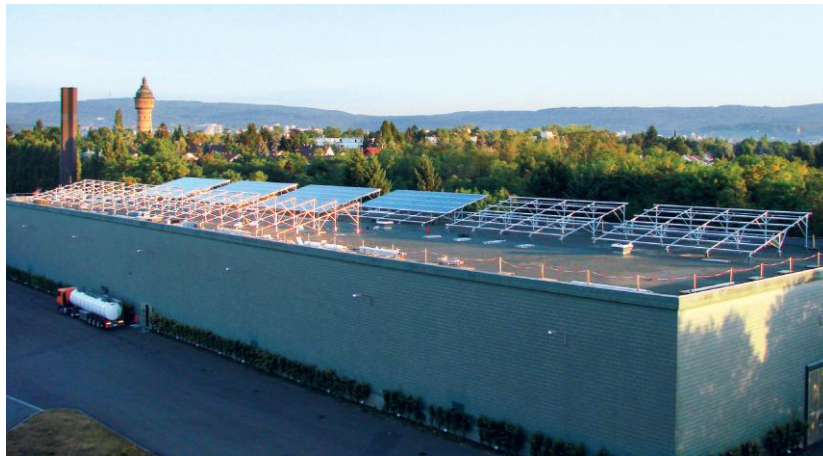
Die Photovoltaikanlage der Henkell & Co. Sektkellerei in ihrer Bauphase.
