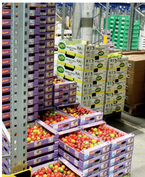
1. Drei Hallenschiffe mit zusammen 25.000 m 2 für Milchprodukte, Obst und Gemüse werden seit April 2014 durch eine Ammoniakkälteanlage mit Pluskälte (6 °C) versorgt. © GEA
