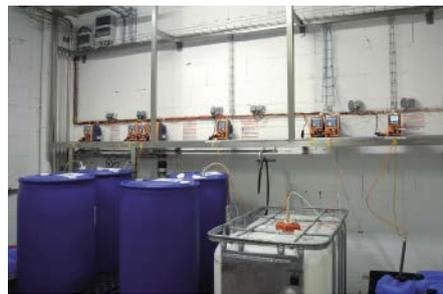
■ **Abb. 3:** Zur Dosierung von Desinfektionsmitteln oder Bandschmierung in der Abfüllhalle setzt Welde die Magnet-Membrandosierpumpe Gamma/x ein.
